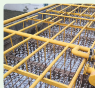
图：好氧池填料更换
