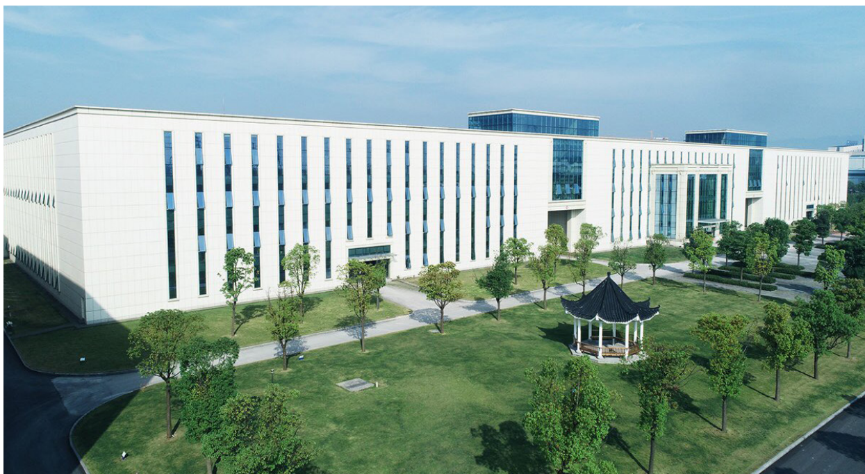
图：药友制药制剂国际化产业基地
