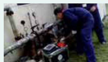
濟民腫瘤醫院檢漏現場
